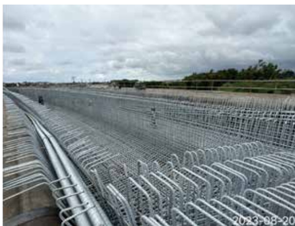
圖 9 橋梁上構底腹板鋼筋綁紮 -1
