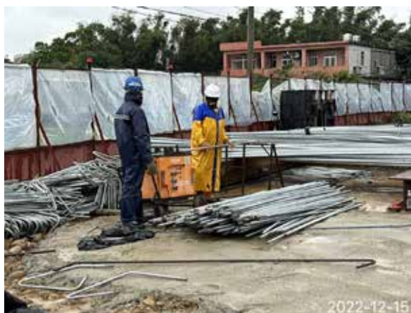
圖 6 鍍鋅鋼筋加工
