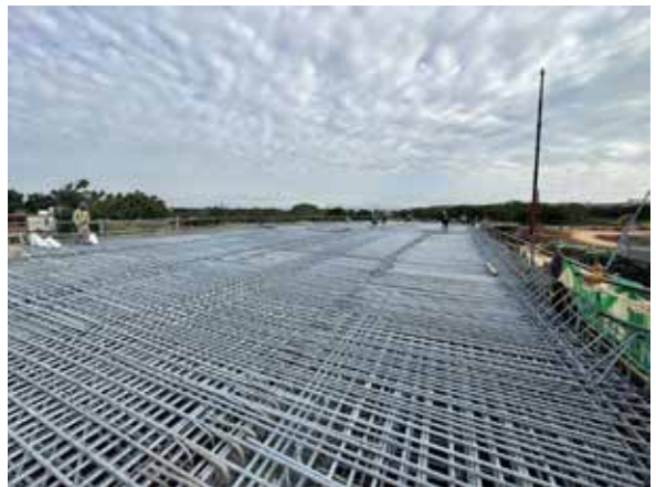
圖 13 橋梁上構頂板鋼筋綁紮 -1
