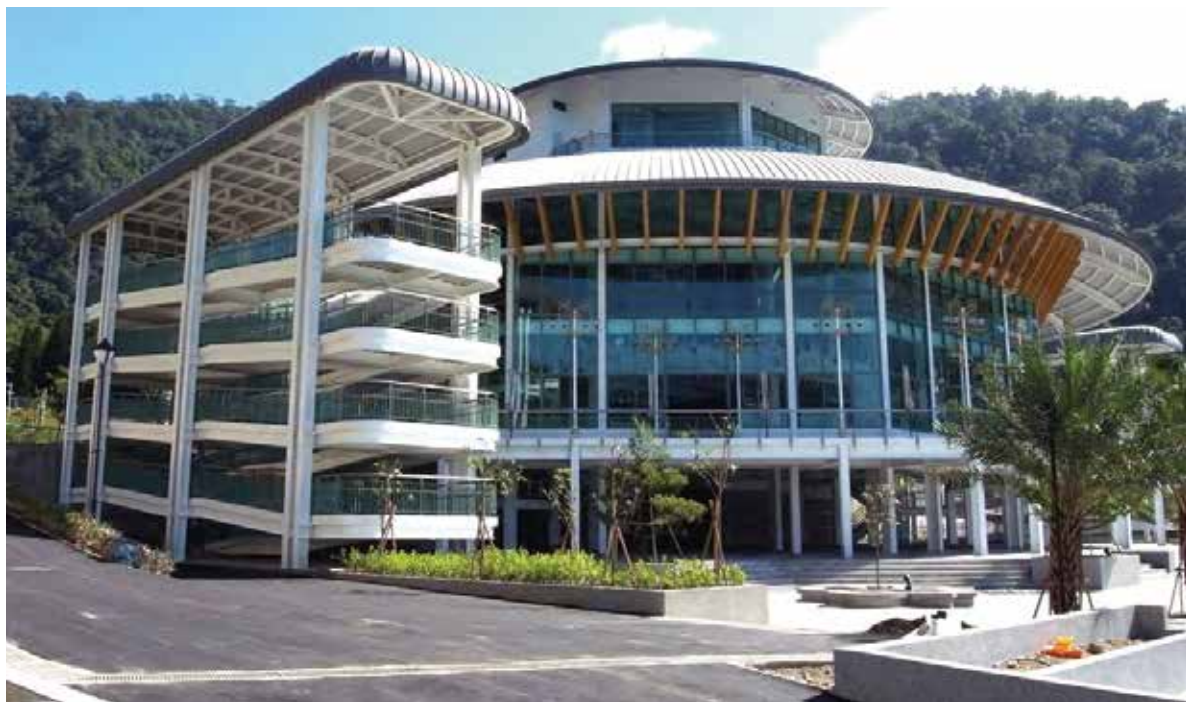
日月潭纜車鋼結構
