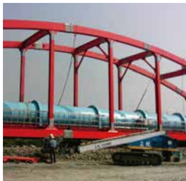
台中大肚溪水管橋
