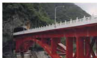
太魯閣砂卡礑溪鐵橋
