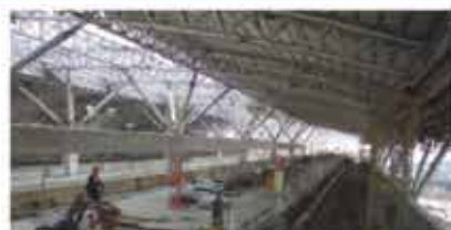
高鐵車站天花板
