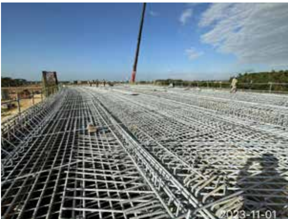
圖 12 橋梁上構頂板鋼筋綁紮
