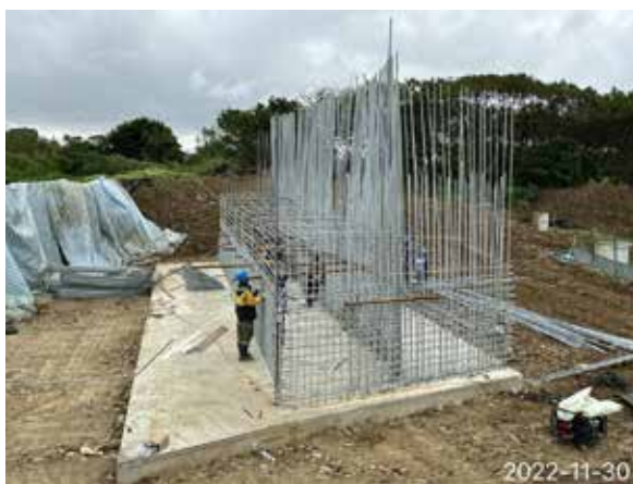
圖 7 橋梁下構墩柱鋼筋綁紮
