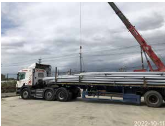
圖 4 鍍鋅鋼筋吊卸
