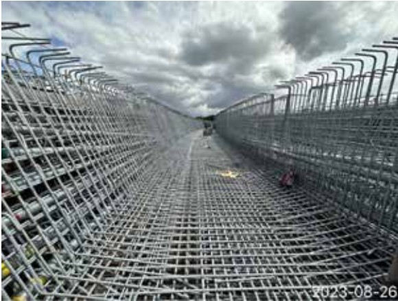
圖 10 橋梁上構底腹板鋼筋綁紮 -2
