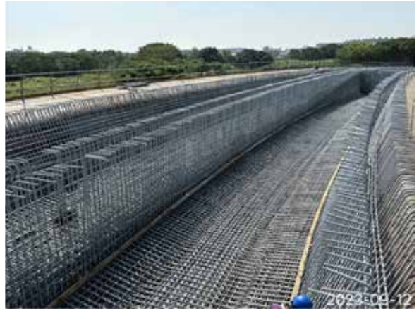
圖 11 橋梁上構底腹板鋼筋綁紮 -3
