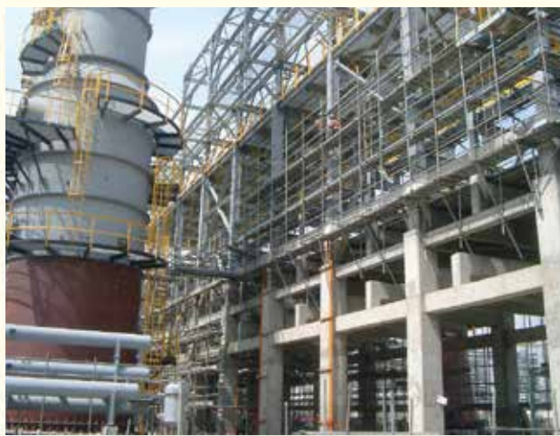
中油林園新六輕廠房結構
