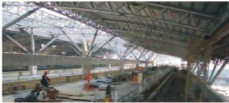
高鐵車站天花板
