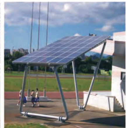
板橋國中太陽光電結構
