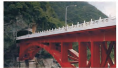
太魯閣砂卡礑溪鐵橋
