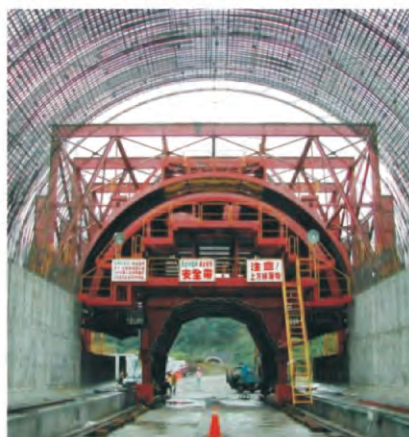
高鐵隧道內外鋼模台車
