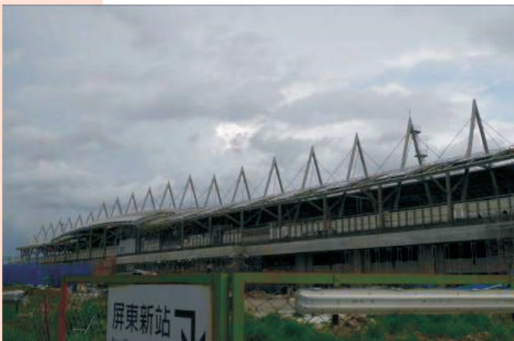
照片一、屏東新站外觀（施工中）
