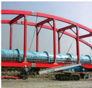
台中大肚溪水管橋
