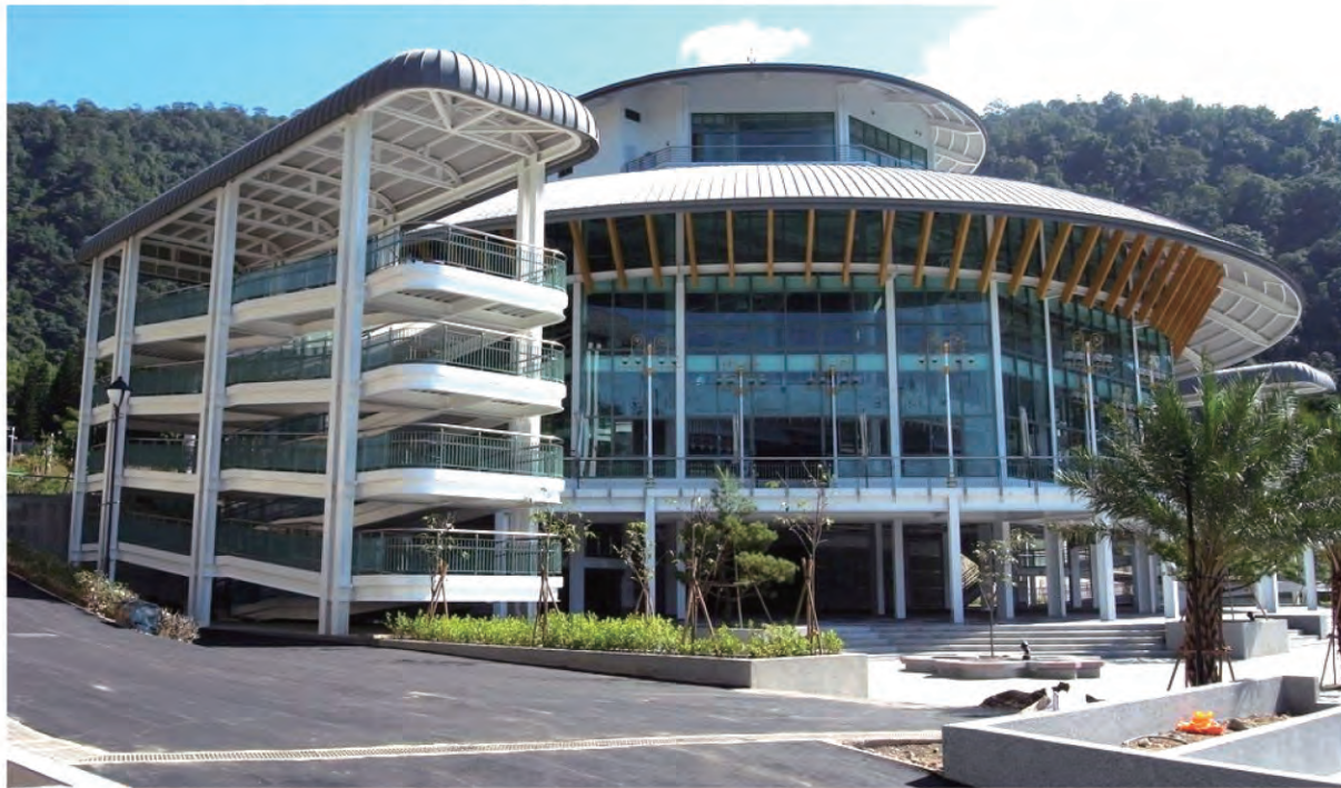
日月潭纜車鋼結構
