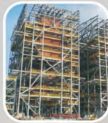
台塑德州案鍋爐鋼構工程
