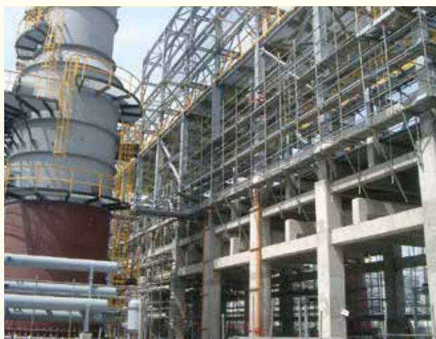
中油林園新六輕廠房結構
