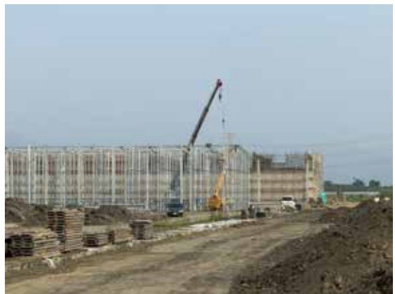
照片 8 工地安裝
