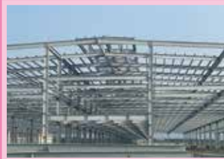
工程名稱：威葦多生技系統化生產工廠 新建工程 業主單位：威葦多農業生技有限公司 鍍鋅單位：易宏熱鍍鋅工業股份有限公司 鍍鋅數量：2,500噸 工程構造：鋼骨結構熱浸鍍鋅
