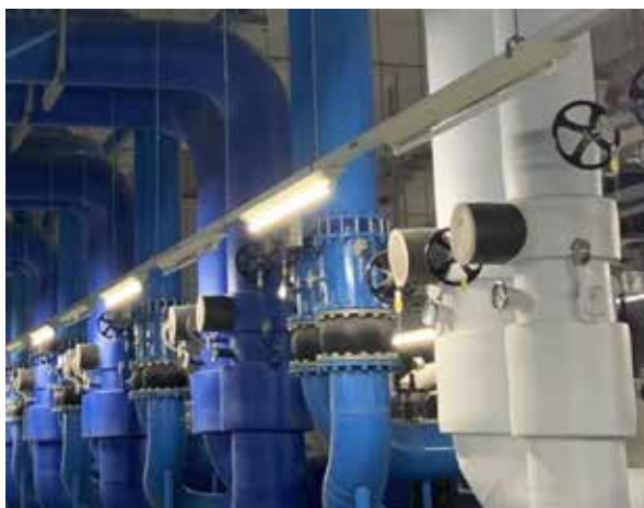
圖 5 SS400-HDG 產品應用於廠房管線
