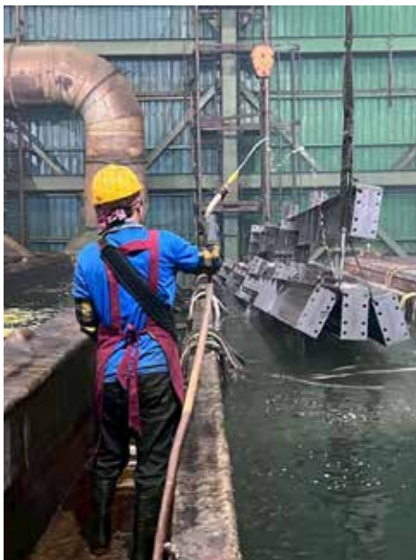
照片 1 酸洗除銹照片
