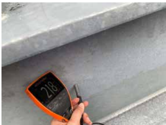
照片 10 膜厚檢查 (腹板)
