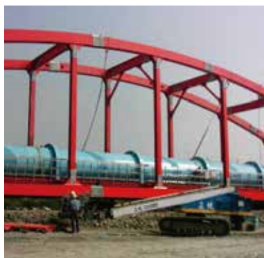
台中大肚溪水管橋
