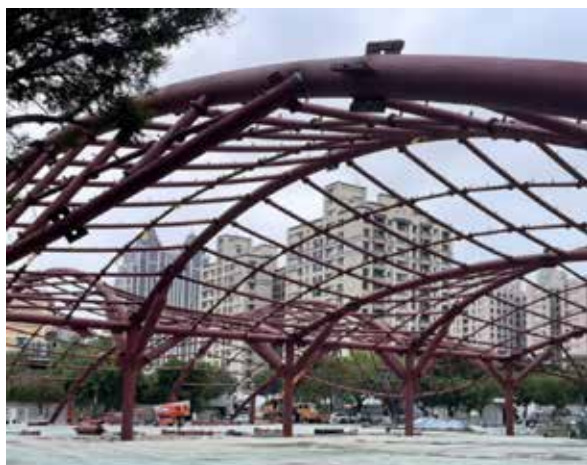
圖 6 SS400-HDG 產品應用於遮陽結構
