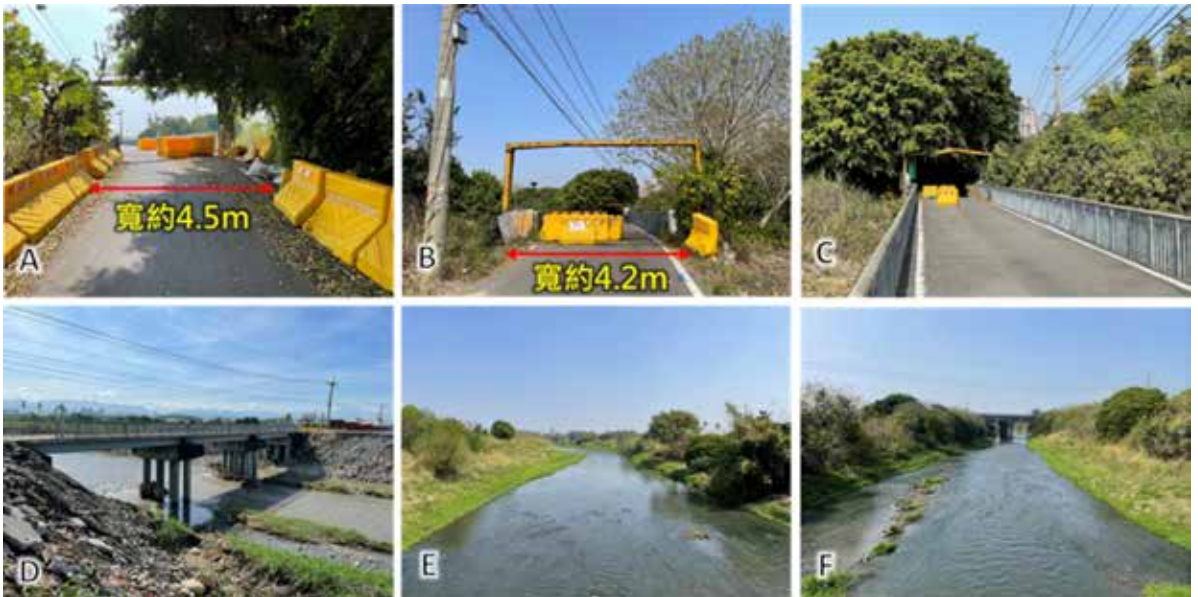
圖 4 施工前工址現況圖
