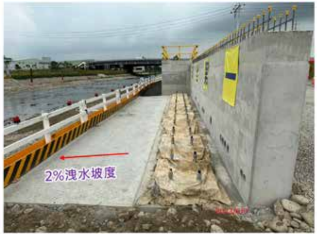
橋台支承平台的短向及護岸平台設置 2% 的坡度
