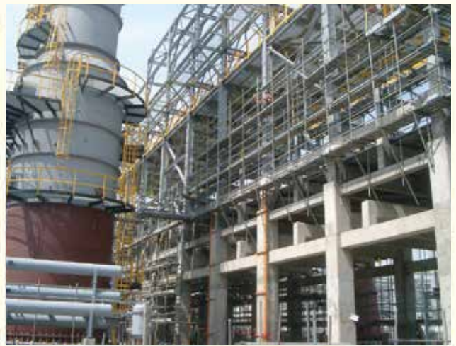
中油林園新六輕廠房結構
