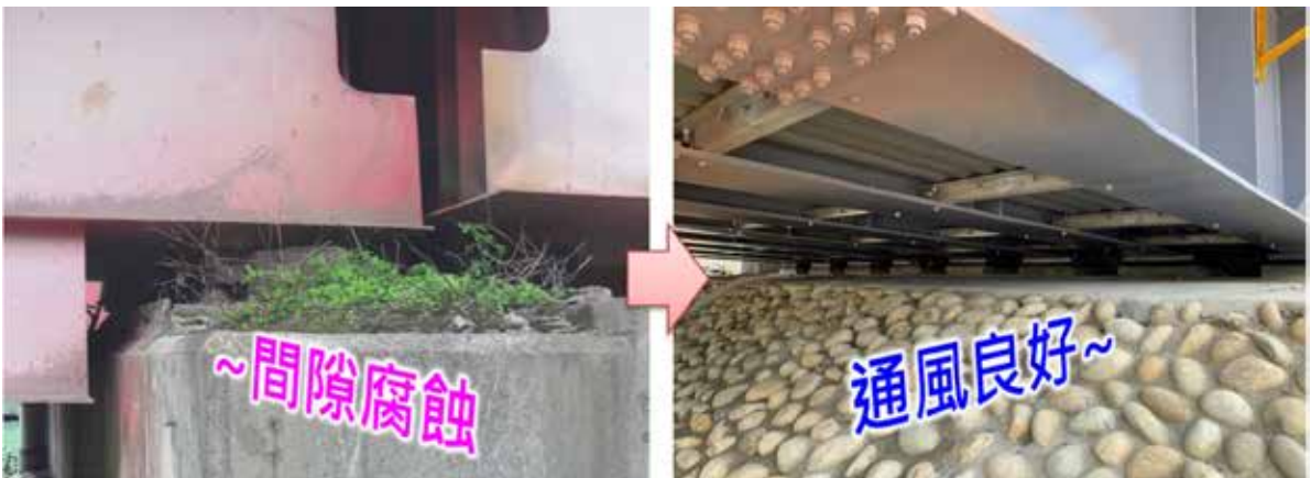
圖 12 橋下避免產生間隙腐蝕
