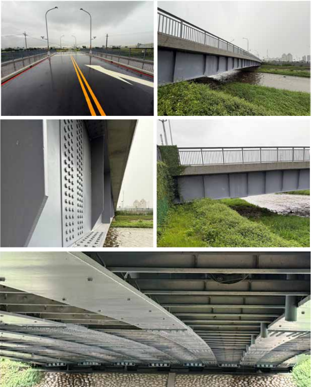
圖 15 光竹橋具備方便安全的檢測動線
