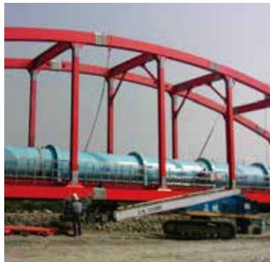
台中大肚溪水管橋
