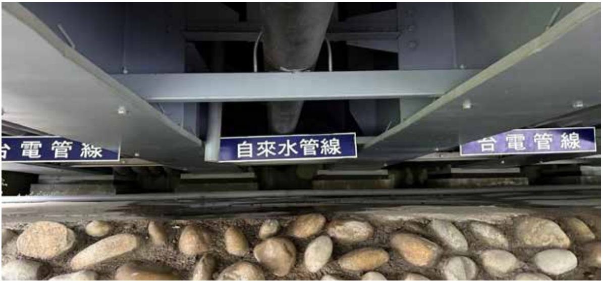
完工後 2 年雨後平台未見積水
