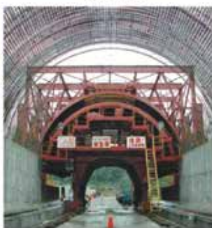
高鐵隧道內外鋼模台車
