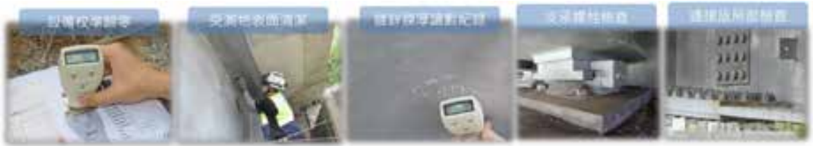
圖 14 鋼梁鍍鋅膜厚檢驗照片
