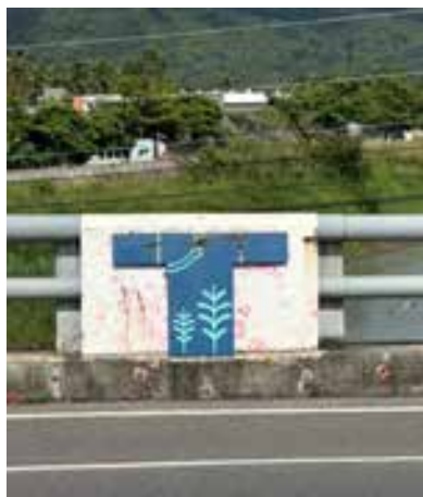
圖 19 欄杆附掛實景
