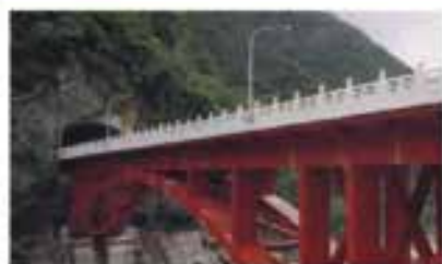
太魯閣砂卡槽溪鐵橋
