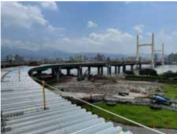
圖 7 現場組裝作業
