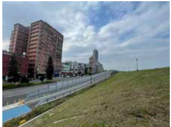
圖 8 (a) 竣工完成
