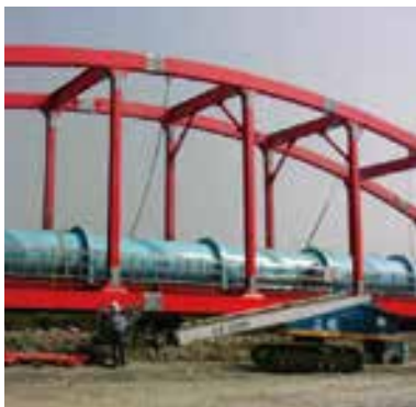
台中大肚溪水管橋
