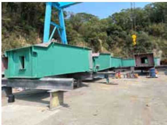
圖 5 箱梁部分塗裝
