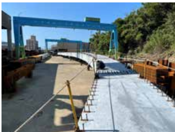
圖 4 箱梁進行預組立
