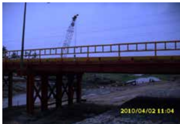
圖 8 臨時鋼便橋照片 (二)
