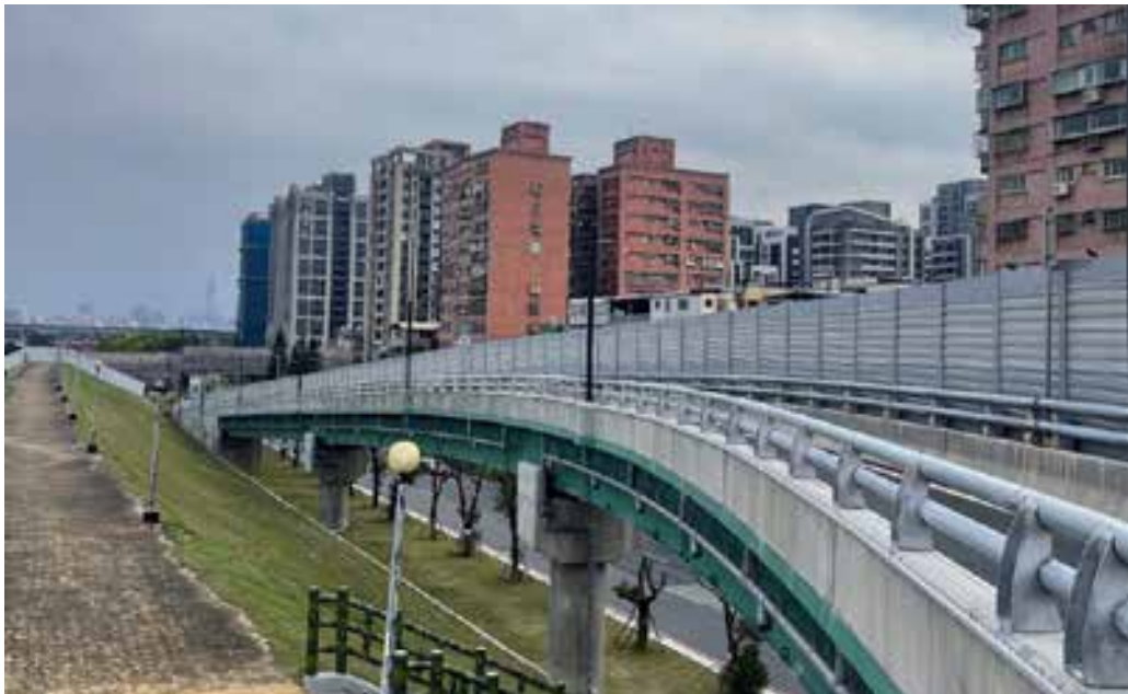
圖 8(b) 竣工完成
