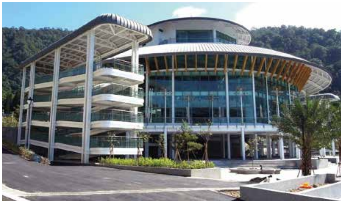
日月潭纜車鋼結構
