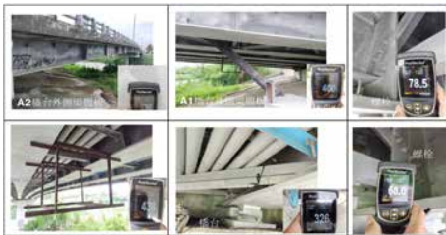
圖 23 中壇橋熱浸鍍鋅構件膜厚實測 (11)
