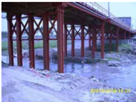
圖 7 臨時鋼便橋照片 (一)
