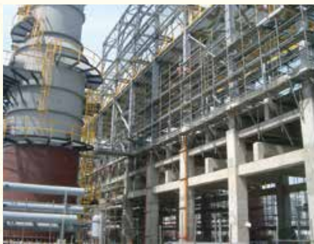
中油林園新六輕廠房結構
