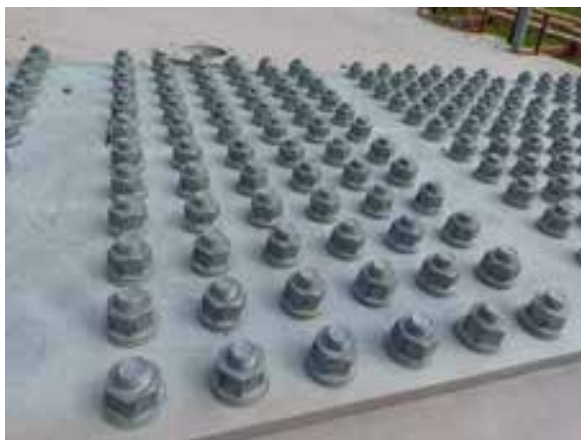
圖 6 箱梁以熱浸鍍鋅 A325 螺栓搭配 DTI 張力指示器組裝
