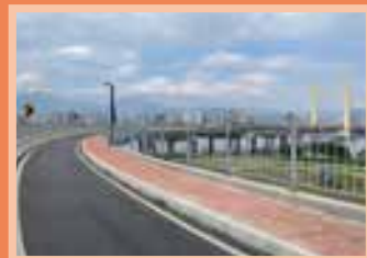
重陽橋三重端增設環河北路二段 往台北方向機車引道工程
