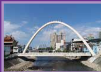
南通橋改建工程
