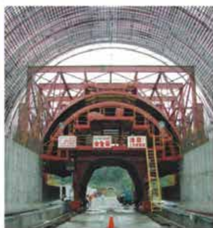
高鐵隧道內外鋼模台車
