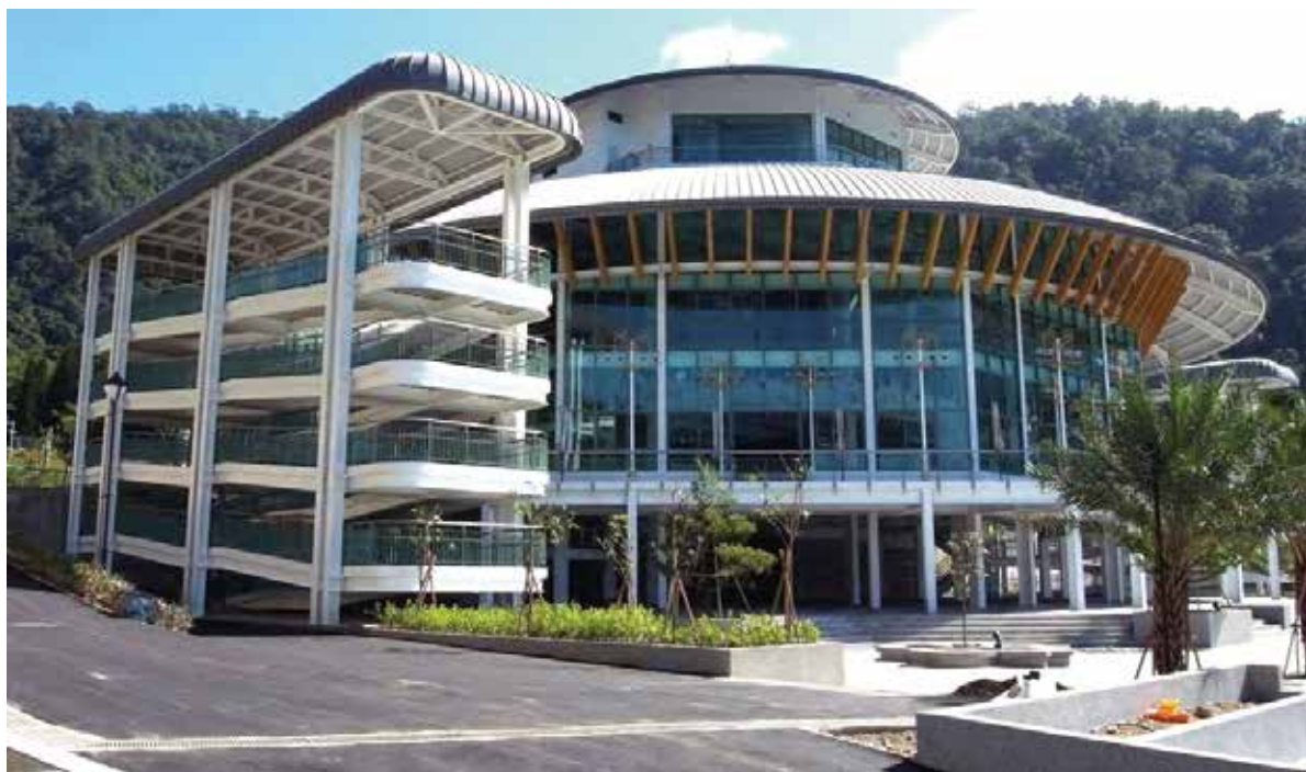
日月潭纜車鋼結構
