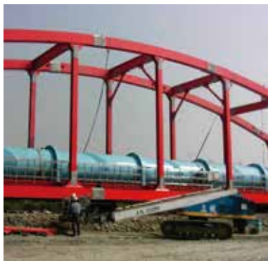
台中大肚溪水管橋
