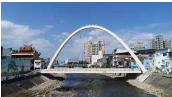
圖 2、斜垮單肋拱鋼拱橋設計
