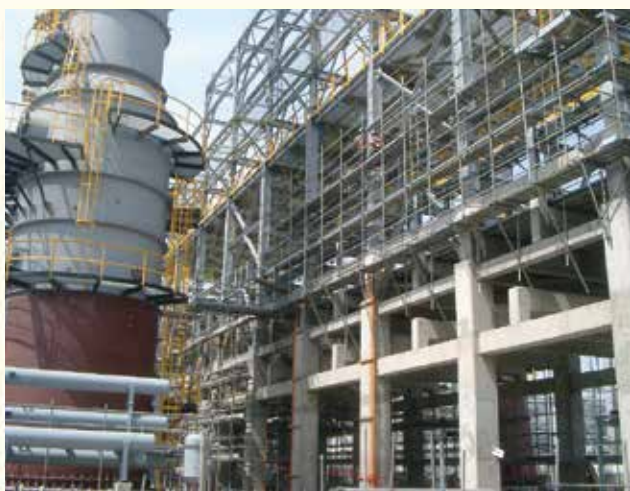
中油林園新六輕廠房結構
