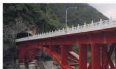
太魯閣砂卡礑溪鐵橋
