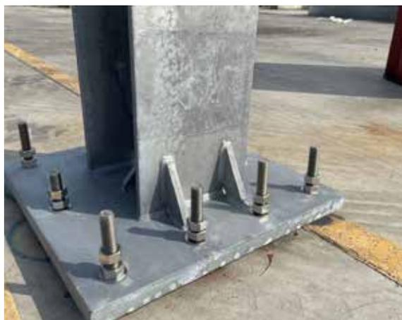
圖4 基礎以不銹鋼螺栓植釘
