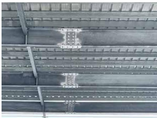
圖5 接合板及螺栓補漆加強防蝕
