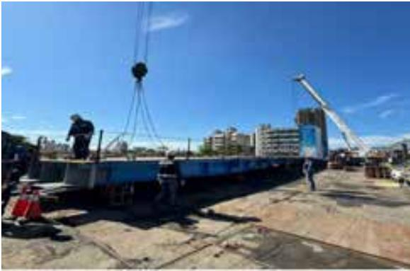
圖 8 鋼橋梁吊裝及安裝工程 -5
