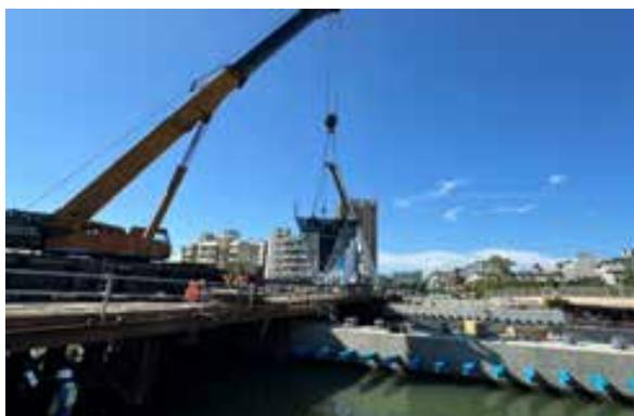
圖 7 鋼橋梁吊裝及安裝工程 -4
