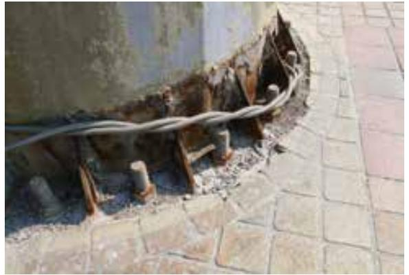
圖 5 舊第五組後導標基礎螺栓銹蝕情形
