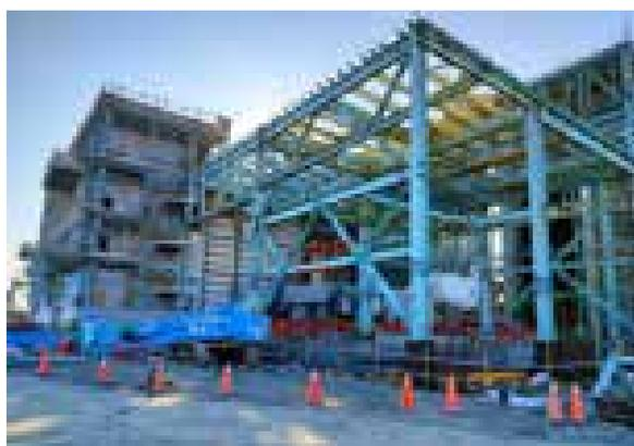
圖 11 興達電廠廠房鋼構熱浸鍍鋅工程 -7
