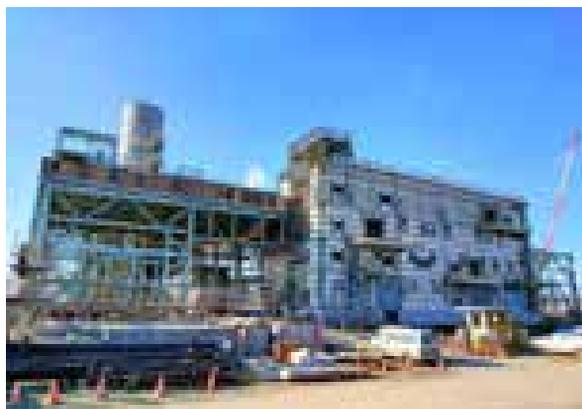
圖 9 興達電廠廠房鋼構熱浸鍍鋅工程 -5
