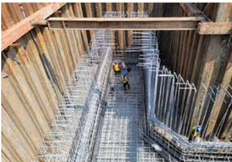
圖 9 現場鋼筋施工
