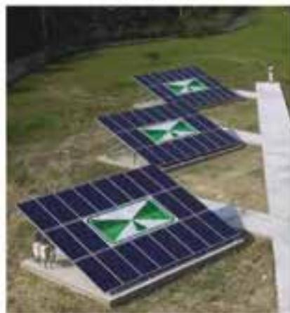
大型鋁合金太陽光電板架
